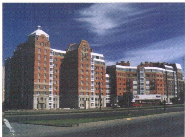
Санкт-Петербург, пр. Энгельса. Велокс использовался при устройстве перегородок и межэтажных перекрытий.
